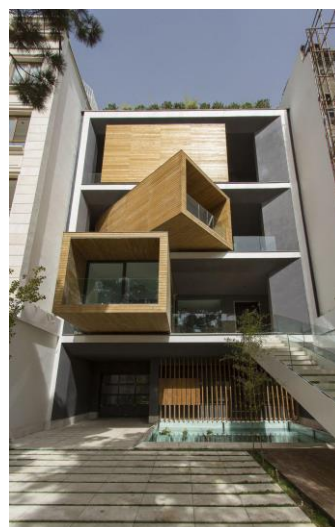
خانه شریفی‌ها، تهران، محله دروس معمار: علیرضا تغابنی اتاق‌ها بر روی ریل می‌چرخند
